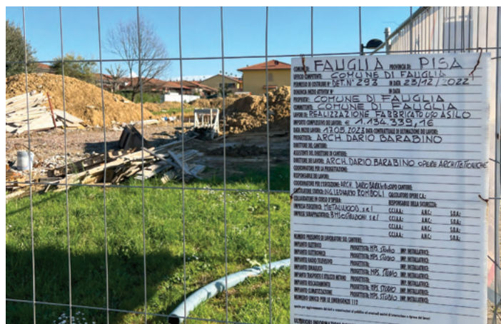
Il cantiere dell'asilo nido di Valtriano
